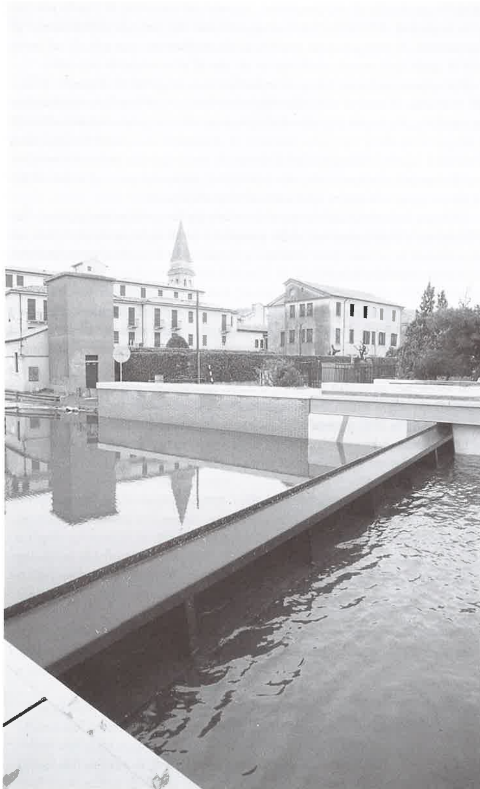
Malamocco. La paratoia in funzione durante l'acqua alta
