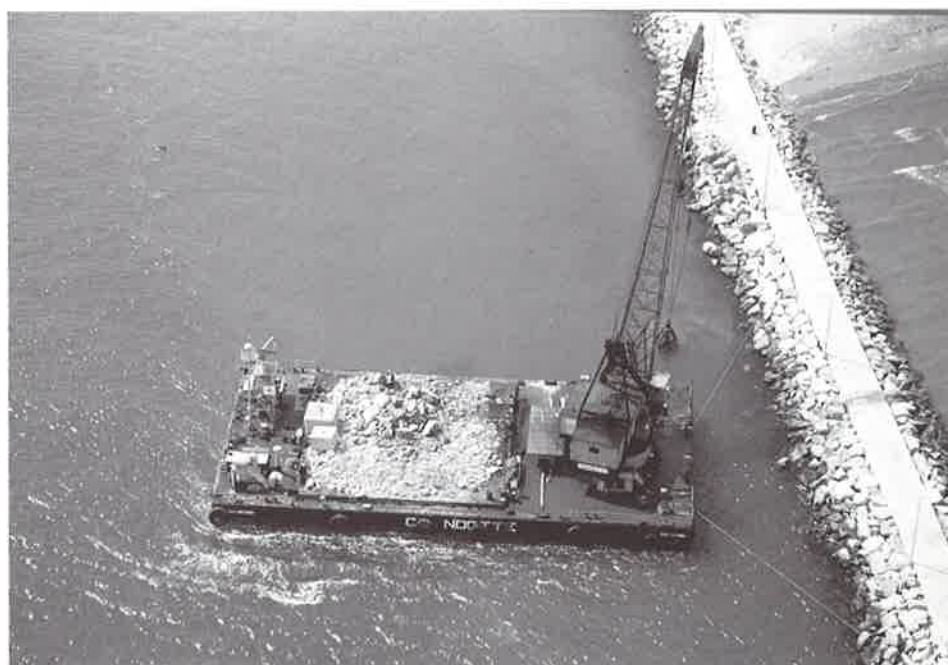
Fig. 5. Molo nord di Malamocco. Lavori di rinforzo lato canale
