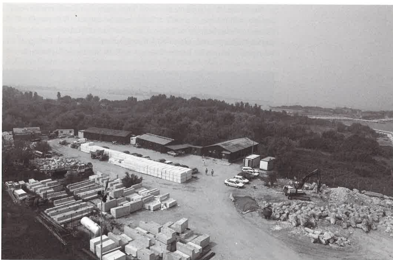
Fig. 4. Ristrutturazione dei molli nord e sud di Chioggia. Area di cantiere
