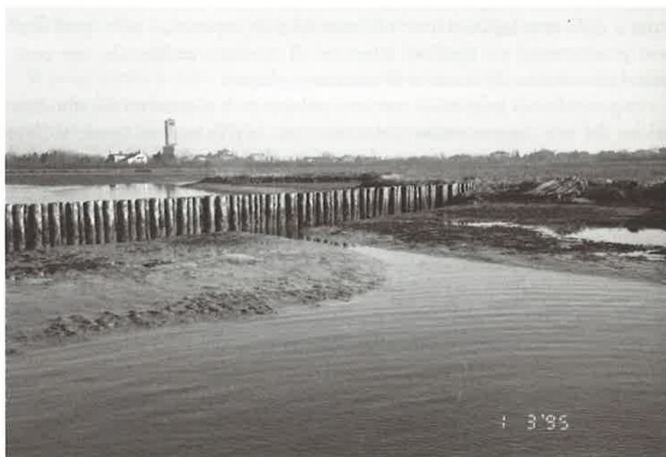
Fig. 2. Palificata lungo il canale Silone. L'effetto è stato quello di favorire, in modo naturale, l'accumulo di sedimenti, evidente nella foto, per compensare l'erosione provocata dal canale
