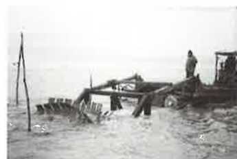
Fig. 3. Macchina per la zappatura del sedimento Figg. 4 e 5. Macchina per l'aratura del sedimento. Nella fotografia grande la macchina in funzione in Palude della Rosa. Sulla macchina è installata la strumentazione visibile nella fotografia piccola in basso
