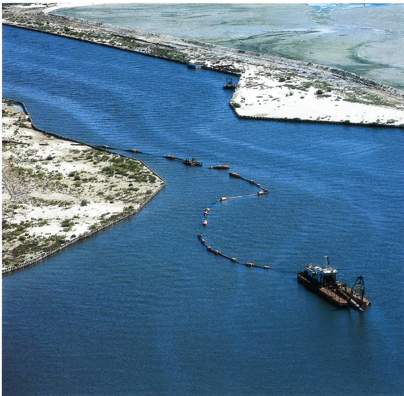
Lavori per il ripristino di barene tra le casse di colmata e Fusina (laguna centrale)
