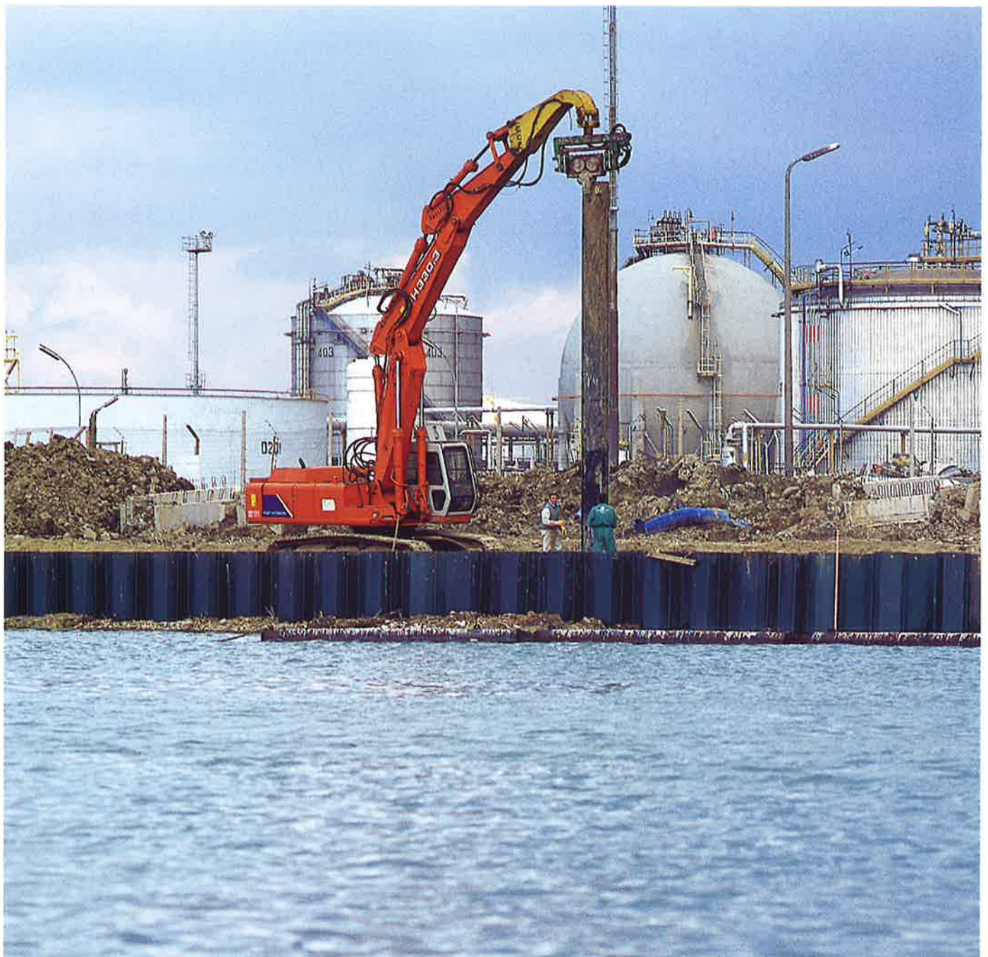
In alto Infissione del palancoato di acciaio a ridosso della riva preesistente
