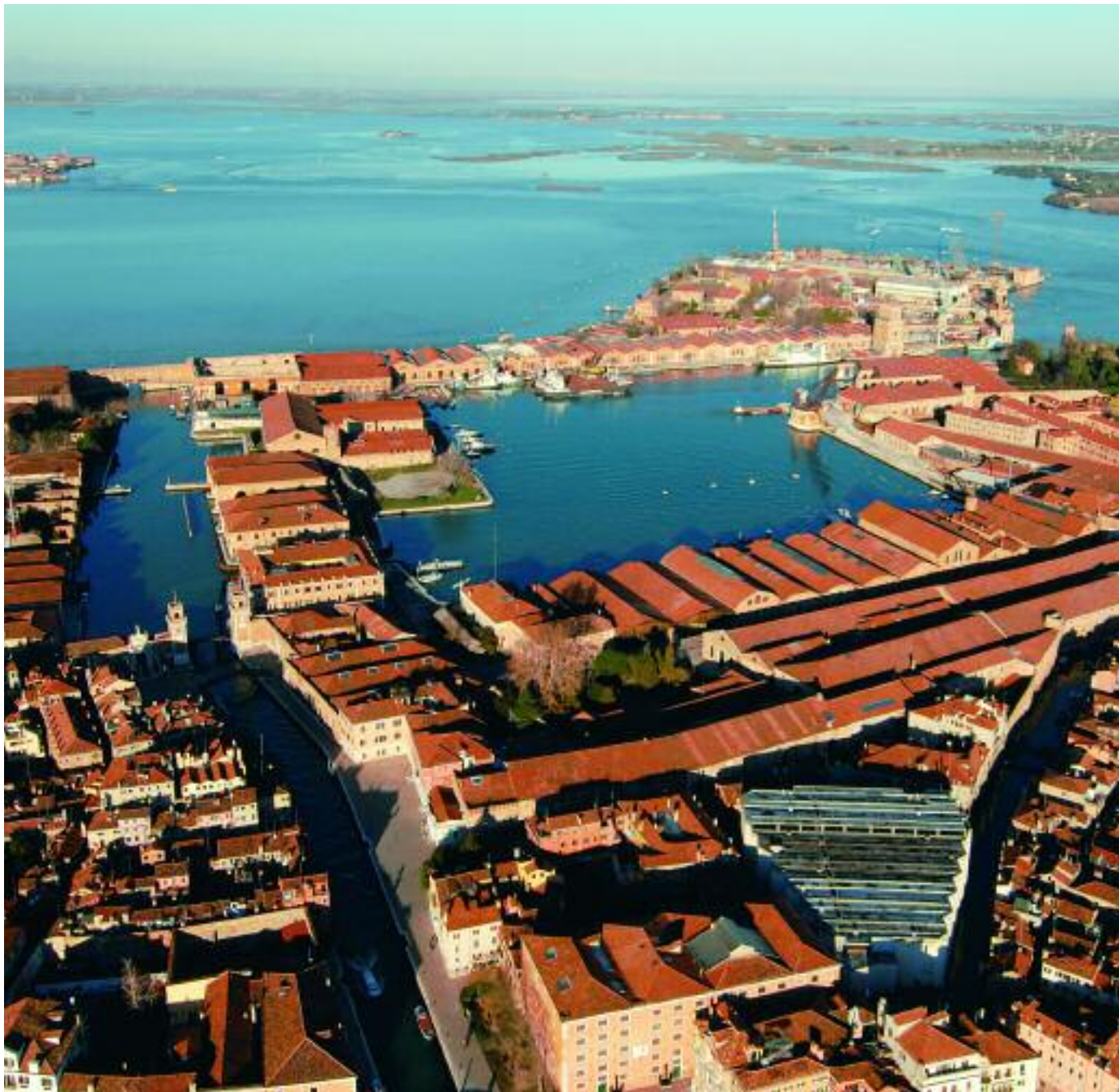
Veduta aerea dell'Arsenale. Al centro il bacino della Darsena Grande
