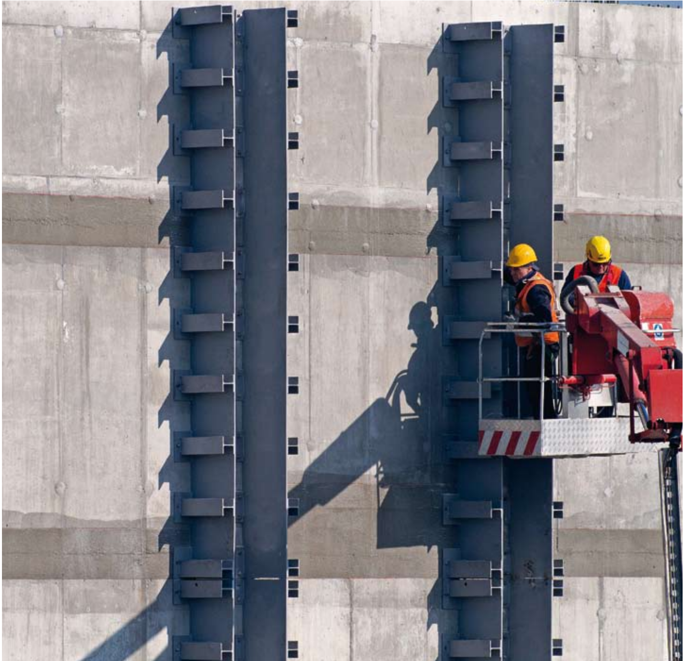
Lavori sulle strutture di "spalla" della barriera di Lido nord
