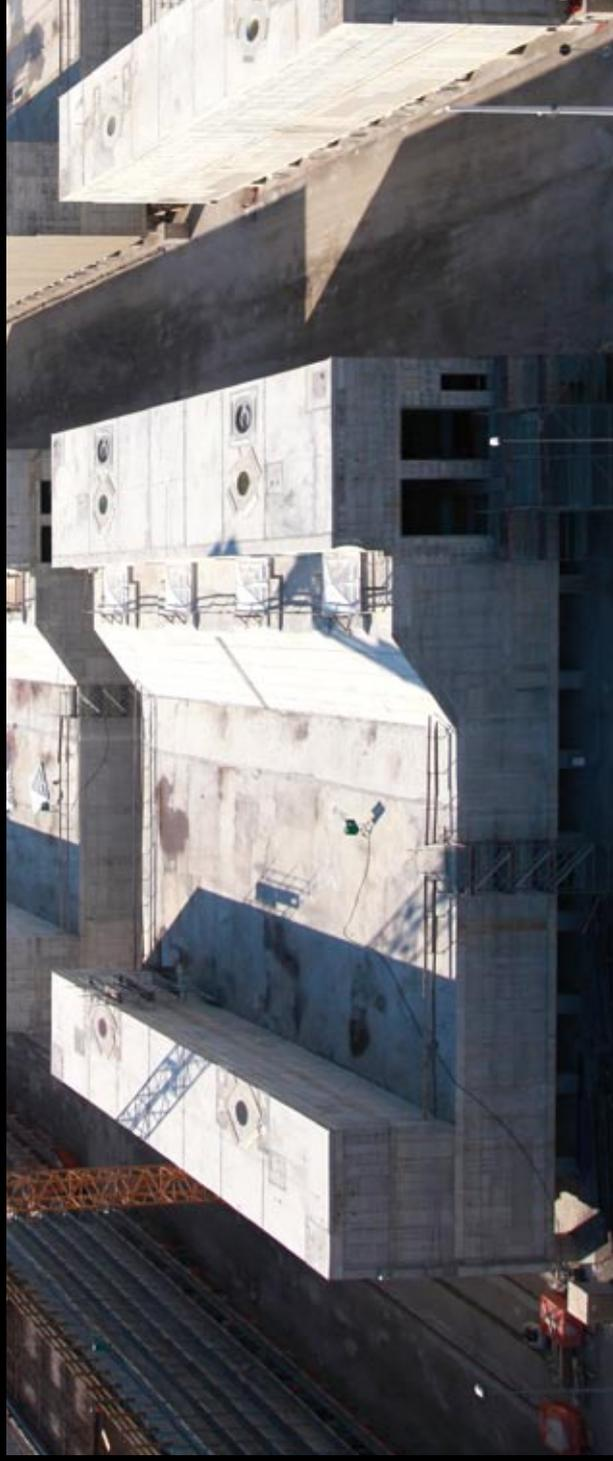
Sul terrapieno sono stati costruiti **7 "alloggiamenti"** e **2 elementi di "spalla"** per la barriera di Lido sud. Altrettante strutture sono state realizzate per la barriera di Malamocco. "Alloggiamenti" e "spalle" sono costruiti sopra una serie di pilastri che tengono le strutture sollevate da terra
