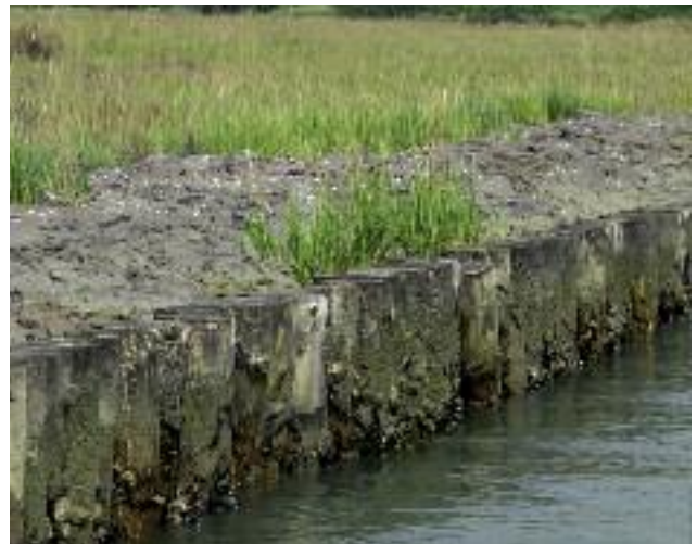
Protezione dei margini barenali mediante conterminazione in pali di legno accostati (interventi di protezione delle barene 1° ciclo, barena Tresso - Laguna nord)
