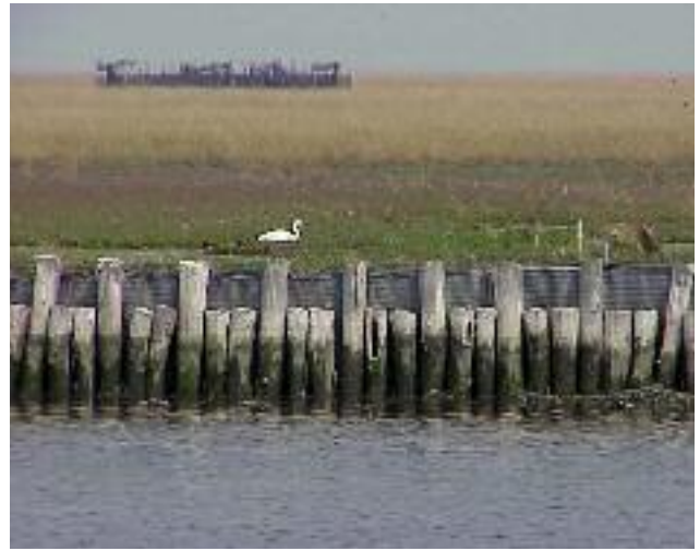
Conterminazione con parete filtrante in pali di legno accostati per la realizzazione di strutture morfologiche artificiali (barena Fossei est - Laguna sud)
