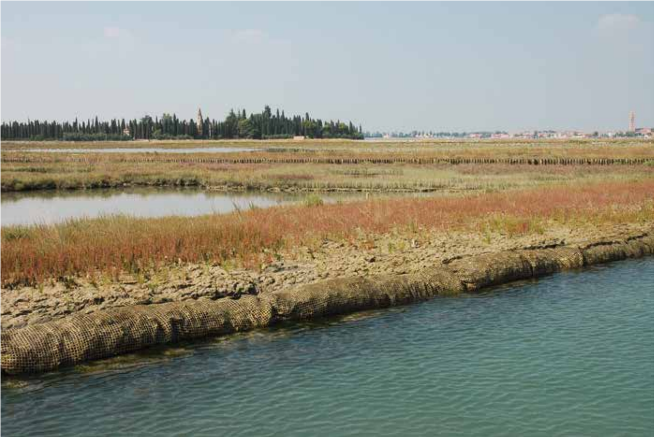
Figura 9. Laguna nord. Schermi frangionda per proteggere i bordi delle barene artificiali e naturali
