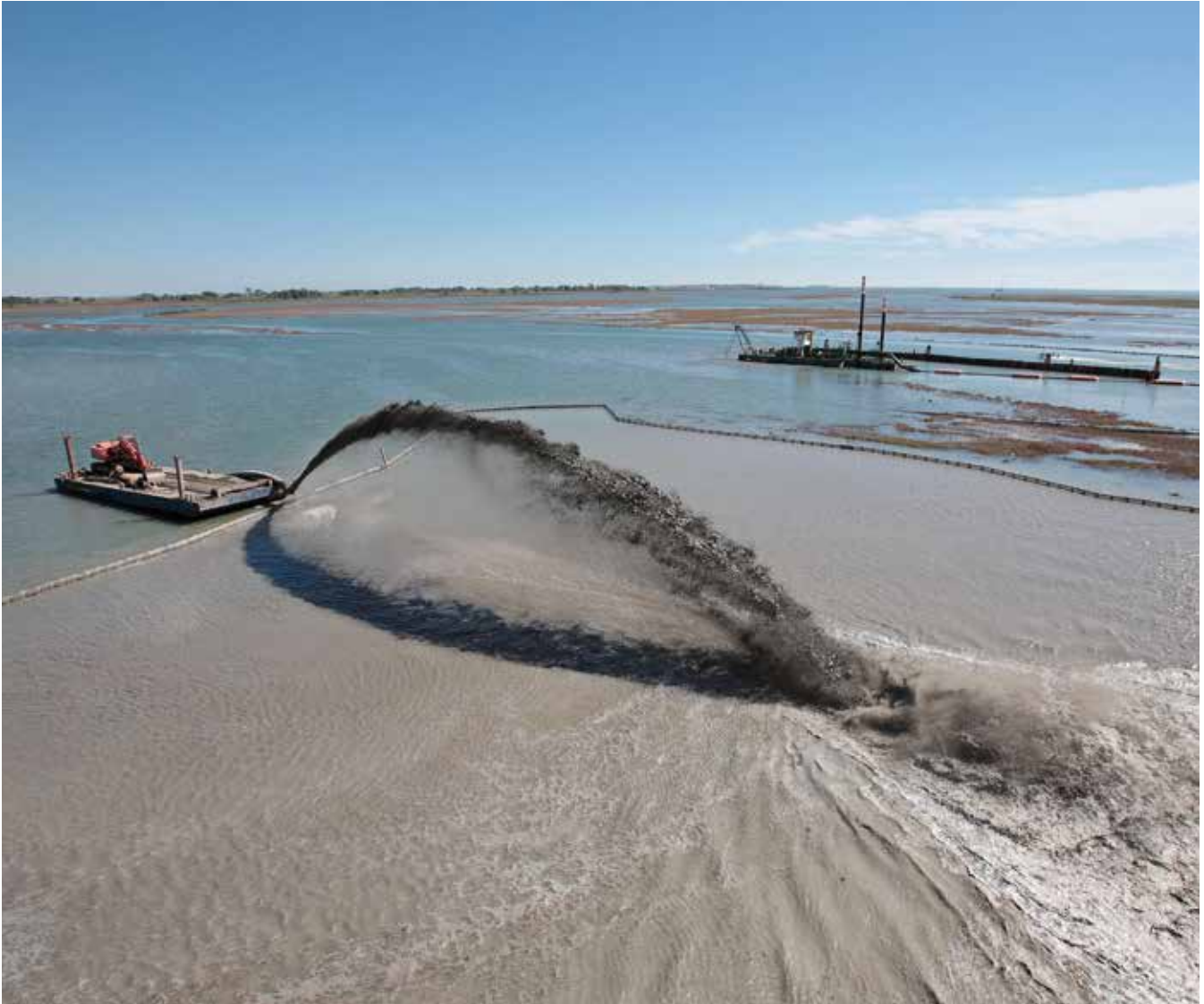
Laguna di Venezia. Lavori per la ricostruzione di barene
