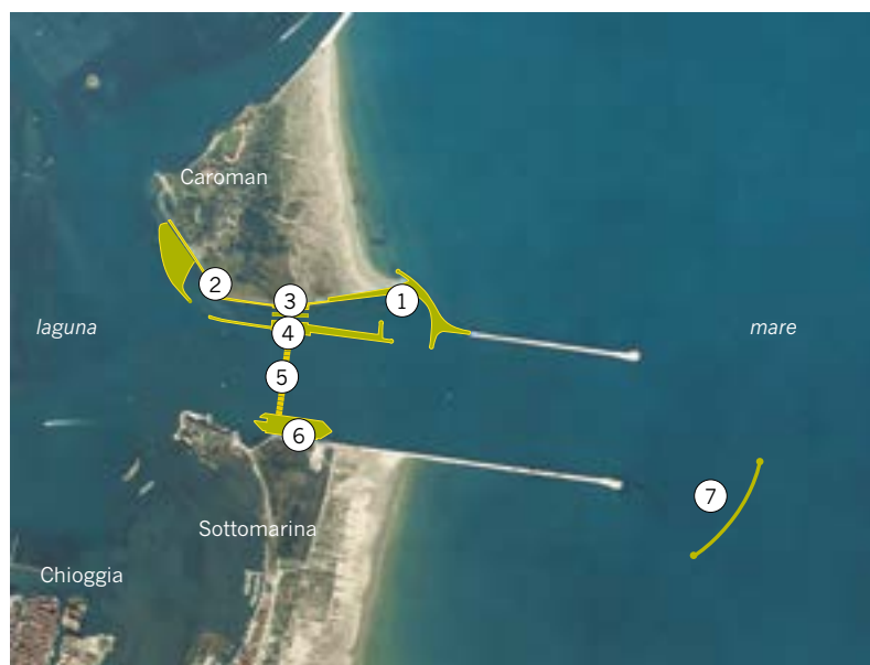
Figura 1. Configurazione della bocca di porto di Chioggia con le opere del Mose
