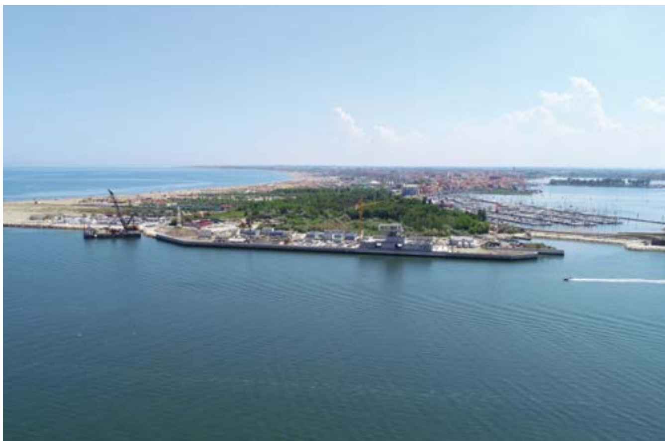
Figura 5. Il cantiere del Mose con l'edificio di controllo in costruzione - 2018 (foto Dronexplore)
