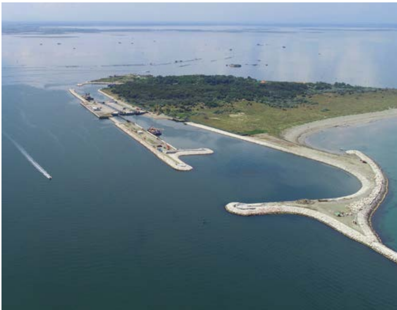
Figura 6. Bocca di porto di Chioggia, spalla Nord. Il porto rifugio lato mare e le conche di navigazione - 2018 (foto Dronexplore)
