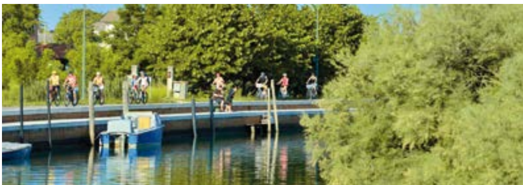
Figura 3. Il nuovo marginamento con pista ciclabile in Via degli Armeni - intervento realizzato (foto da: www.cavallino.info )
