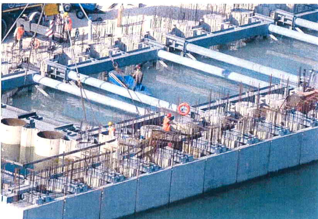
FIG. 1.1 - CONCA DI MALAMOCCHO - REALIZZAZIONE DELL'ALLOGGIAMENTO PORTE LATO MARE
