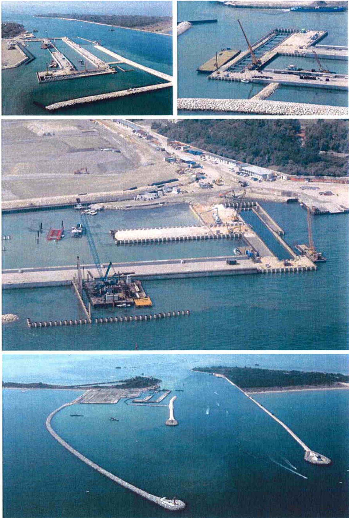
FIG. 1.2 - LAVORI ALLA CONCA DI MALAMOCCO (2007)
