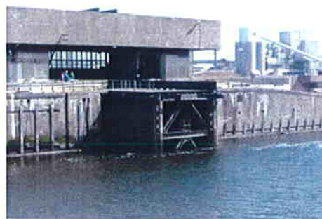
FIG. 12.2 - DUE FASI DI APERTURA DELLA PORTA A SCORRIMENTO (CONCA DI IMUIJDEN)
