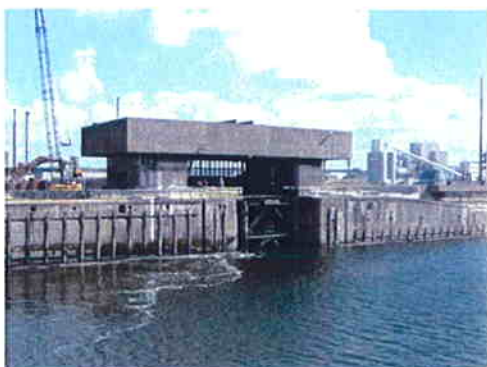
FIG. 12.2 - DUE FASI DI APERTURA DELLA PORTA A SCORRIMENTO (CONCA DI IMUIJDEN)
