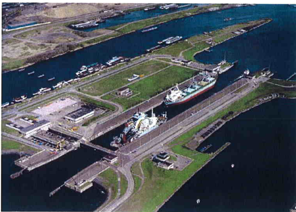
FIG. 12.1 - IMMAGINE AEREA DELLA CONCA DI IMUIJDEN (CAMERA CONCA 50MX400M)
