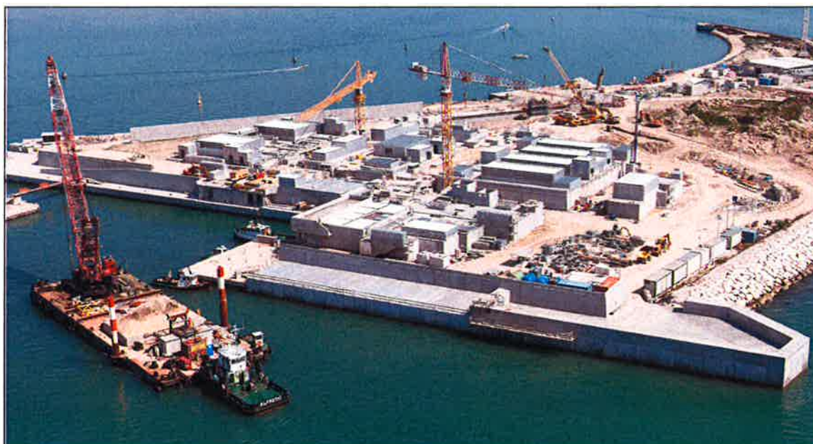
FIG. 3.2 - STATO DEI LAVORI ALLA SPALLA NORD DI S.NICOLÒ (SETTEMBRE 2013)
